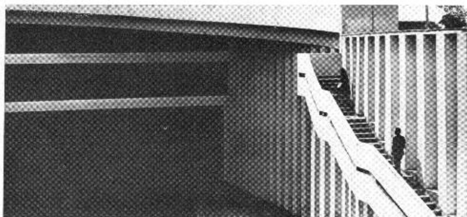
Acesso da ligação leste-oeste à praça, vendo-se os dois níveis de estacionamento, voltadas para a rua Augusta
